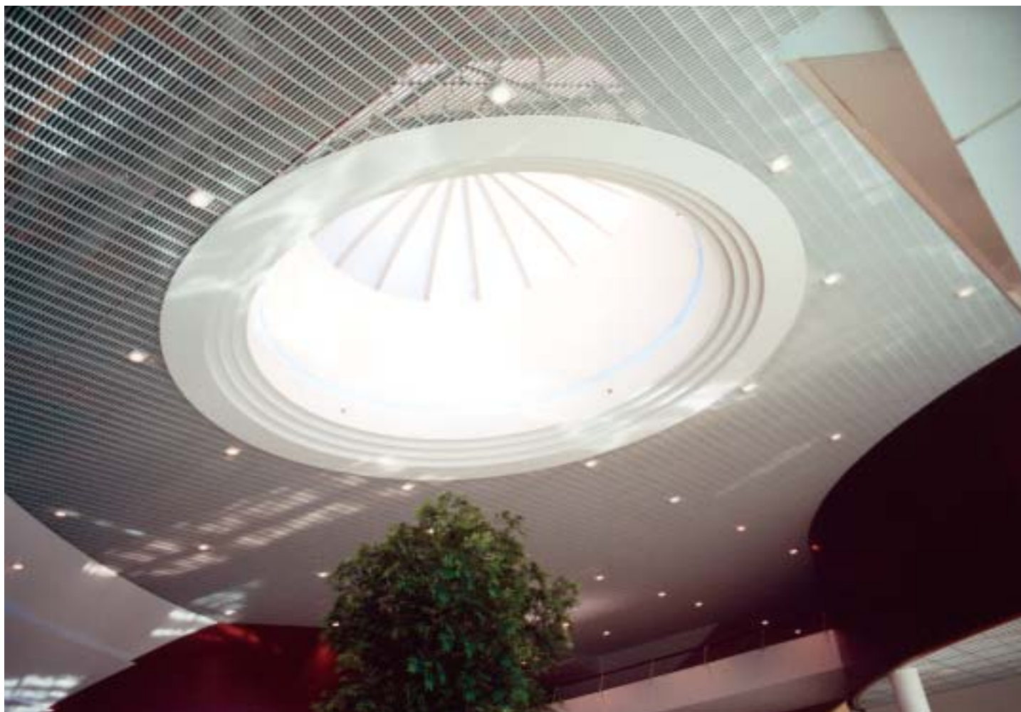
Centre commercial, Vannes (56) Vertigrille pose traditionnelle
